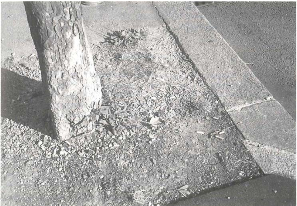
Abb. 4: In den Boden eingesenkte Stellen treten oft bei älteren Baumscheiben auf, und die lückige oder gar spärliche Pflanzendecke zeugt von starkem Betreten.
